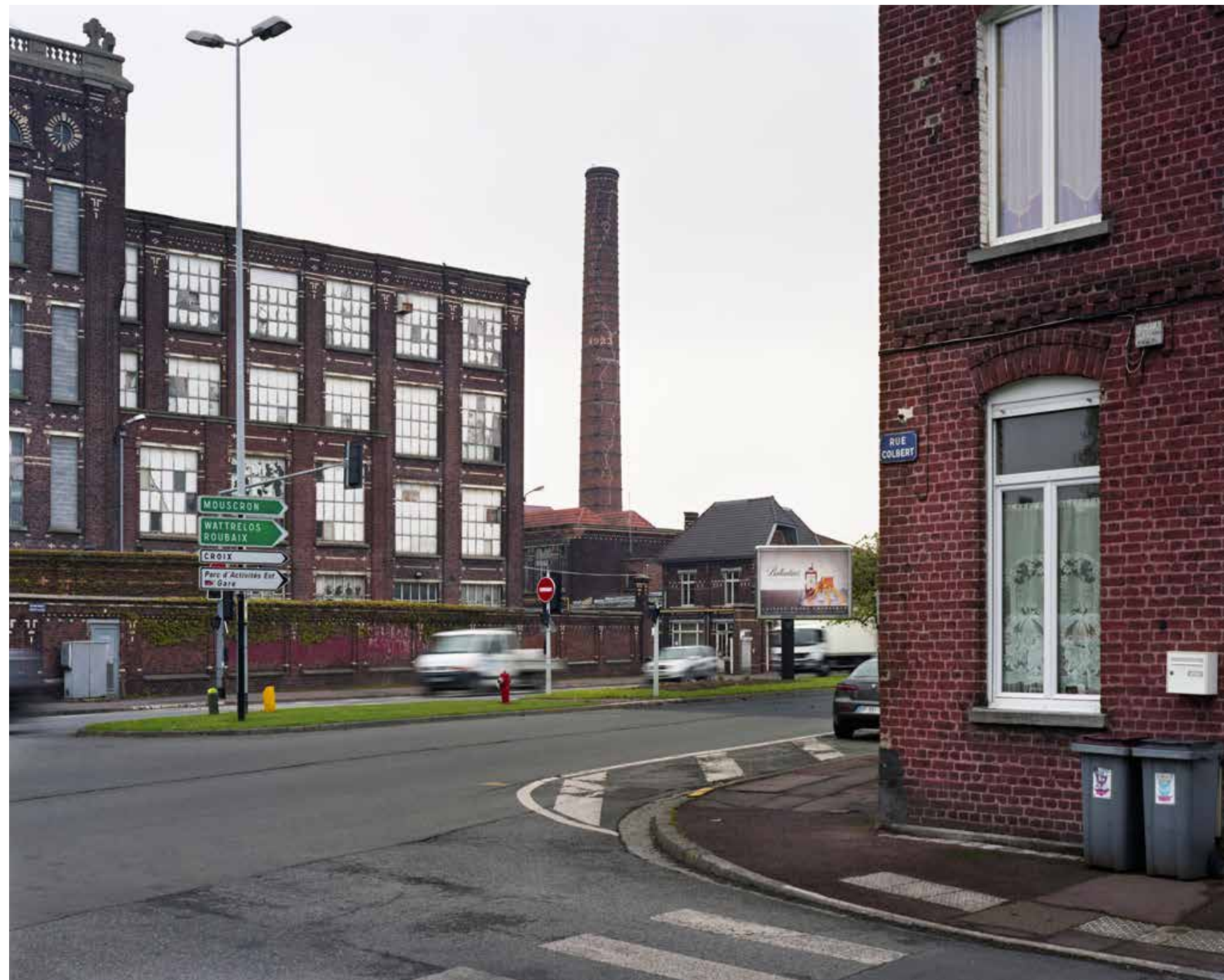
Cheminée de l'usine Louis Lepoutre - 45 mètres / 1923 / Tourcoing / Ancien tissage
